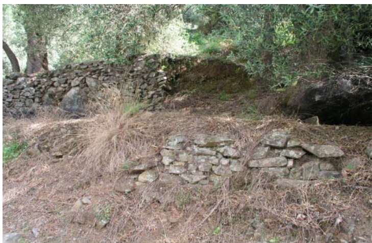
Εικ.4. Η έλλειψη συντήρησης είναι εμφανής στις ξερολιθιές
